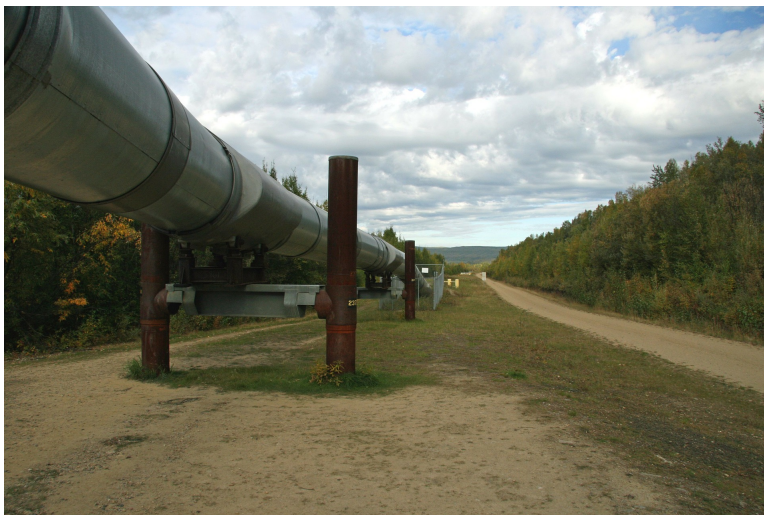
Figura 1.1 Oleoducto, ejemplo de estructura lineal.
