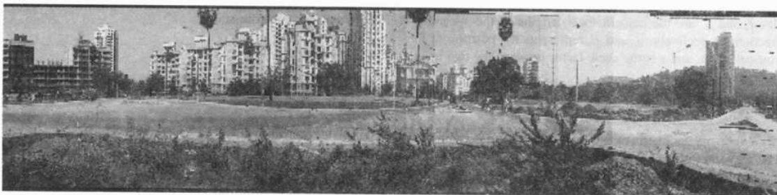
Figura 2.8 Panorámica construida con 32 imágenes del Hiranandani Gardens, Mumbai, India. Fuente: [11].
