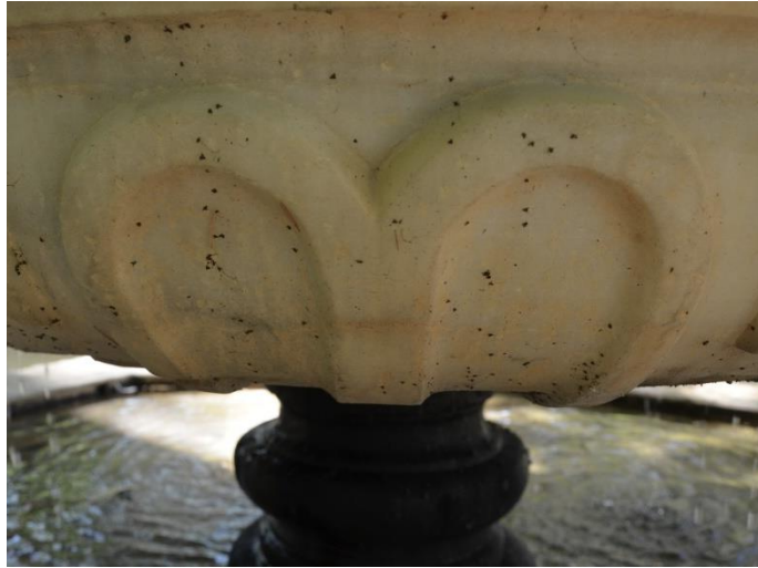
Figura 11. Moteado en la superficie llevado a cabo por insectos. (Calvo, 2019).
