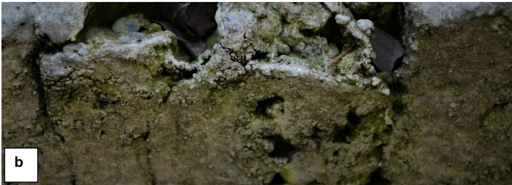
Figura 16. Concreciones. (Calvo, 2019).
