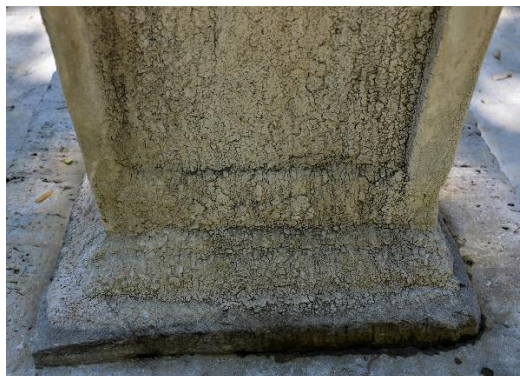
Figura 27. Proceso de descamación. (Calvo, 2019).
