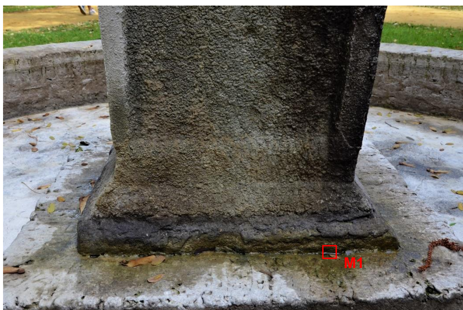
Figura 32. Extracción de la muestra número 1. Tomada de la fuente sin funcionamiento ubicada en el Jardín Inglés. (Calvo, 2019).
