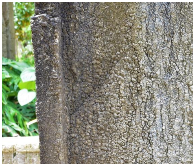
Figura 19. Vermiculación. (Calvo, 2019).
