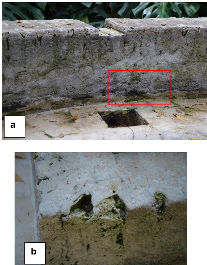
Figura 20. Presencia de cavernas en el material pétreo. (Calvo, 2019).
