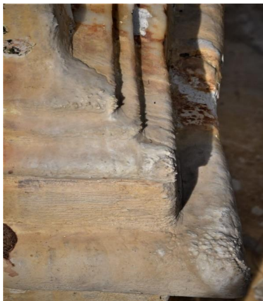
Figura 17. Eflorescencias salinas en la superficie del material. (Calvo, 2019).
