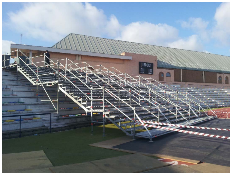
Escalera desmontable instalada para el acceso a pista desde las gradas.
