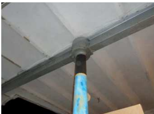
Encuentro columna-viga./ Fotografía realizada por autora.
