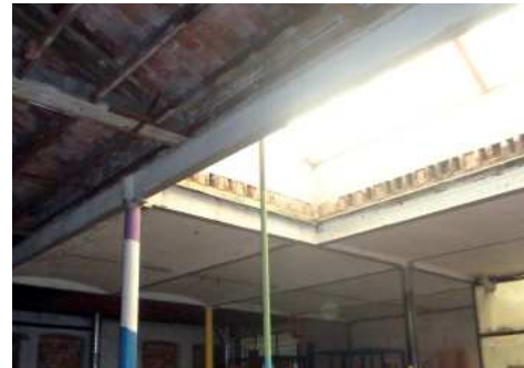
Vista interior cubierta plana y encuentro con lucernario./ Fotografía realizada por autora.
