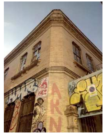
Fábrica, esquina fachadas sur-este./ Fotografía realizada por la autora.
