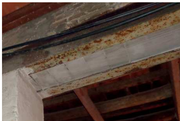
Viga doble del forjado de la primera planta./ Fotografía realizada por autora.
