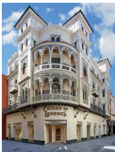
F.7.Edif. Ciudad de Londres, calle Cerrajería, Sevilla./ ABC.
