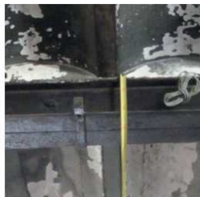
Encuentro viga-vigueta./ Fotografía realizada por autora.
