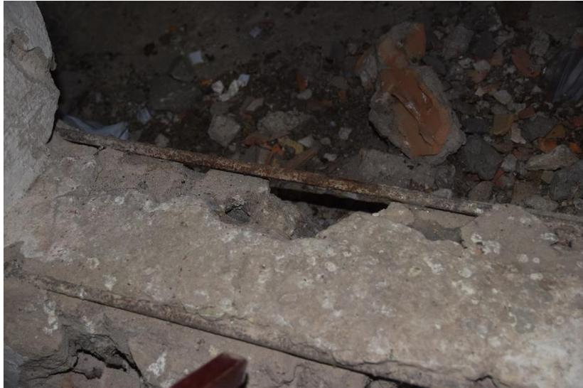
Detalle del armado del muro de las celdas laterales que apoyan en el suelo. Se aprecia de fondo los escombros de ladrillos, fruto del desmantelamiento del marco de carpintería. Fuente: *propia*.
