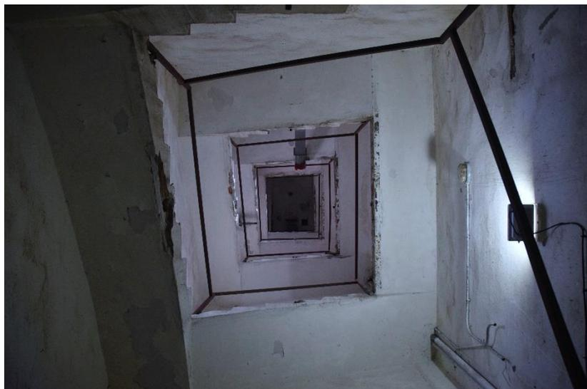
Fotografía del ojo de la escalera, por donde ascendía el elevador que llevaba el grano hasta las celdas centrales, y donde se contempla el mal estado general de las losas de escalera. Fuente: *propia*.
