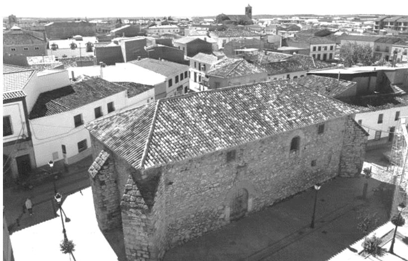
Imagen de la Tercia de La Mota (Cuenca), de planta rectangular, con contrafuertes en sus caras menores, y donde apreciamos la arquitectura vernácula que rige sus conceptos compositivos y constructivos.
