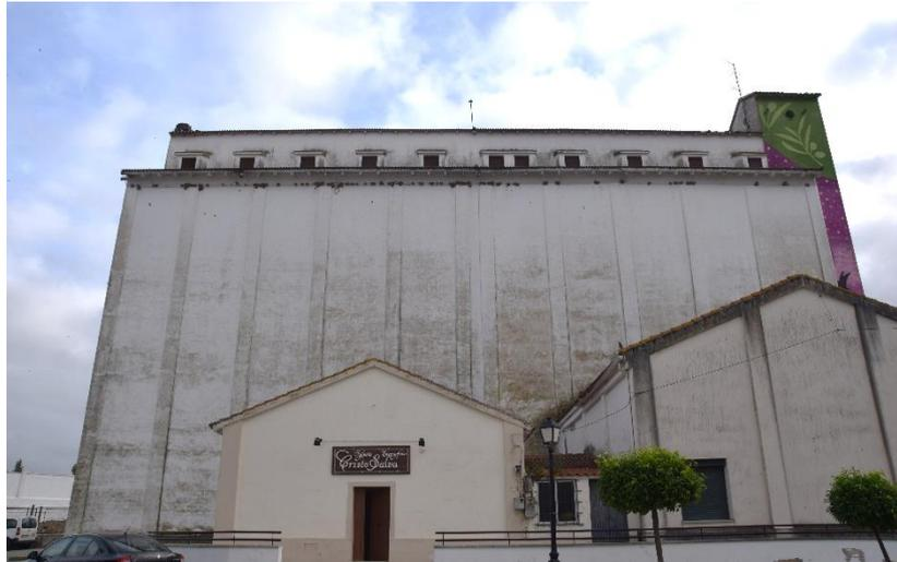
Fotografía de la fachada este del silo, donde se aprecian las dos naves incorporadas en el 81, y el aspecto de deterioro que presentan las fachadas, así como los nidos de los pájaros. Fuente: *propia*.
