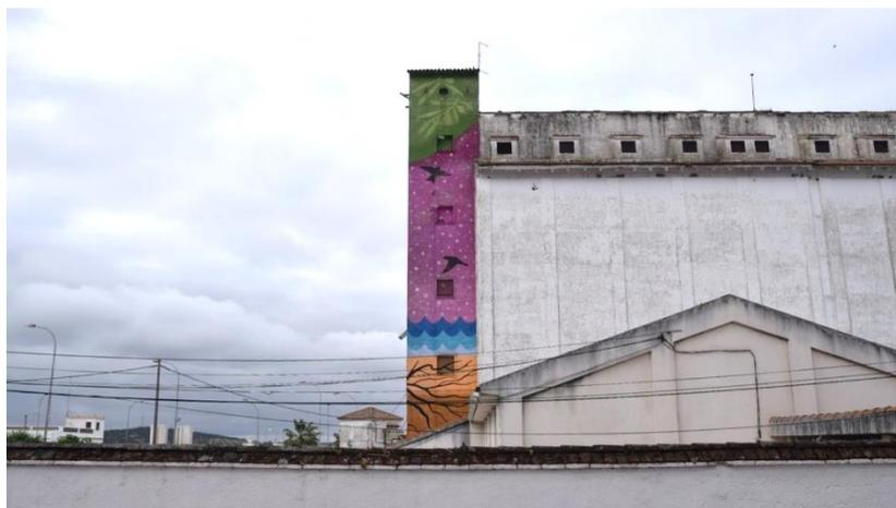
Arriba, la fachada lateral del silo, donde se aprecian las lesiones y los huecos tapados en la torre; abajo, detalle de los huecos sin carpintería y los nidos existentes en los vuelos de la cubierta, y sobre la misma. Fuente: *propia*.
