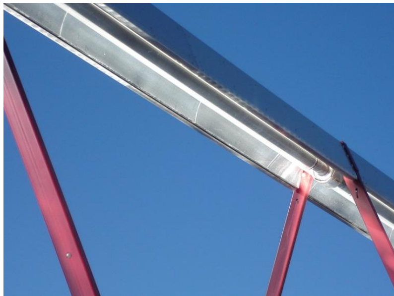
Figura 2.7 Tubo receptor/absorbedor y espejos secundarios.
