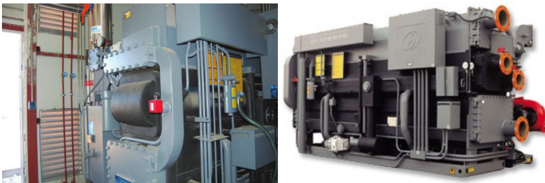
Figura 4.3 Máquina de Absorción de la ETSI de la Universidad de Sevilla. Máquina de doble efecto con ciclo LiBr/agua, modelo BROAD-BZH15 fabricado en China.
