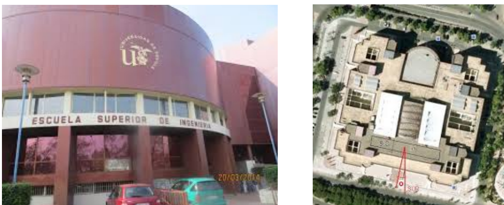
Figura 1.1 Fachada del edificio principal de la ETSI de Sevilla (izquierda). Situación de los colectores solares en la azotea de uno de los edificios de la ETSI (derecha).
