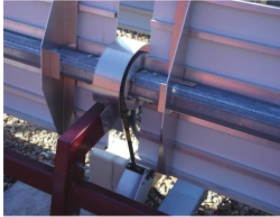
Figura 2.8 Mecanismos de arrastre y control para el seguimiento solar de los concentradores. En este caso, se encuentra en vertical y no proyecta la luz solar al tubo absorbedor, es decir, esta en modo de seguridad.
