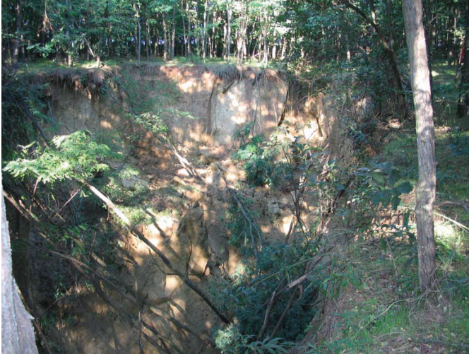
12. kép. III. csoportba tartozó vízmosás részlete közvetlenül egy headcut alatt
