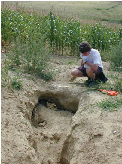
1. kép Beszakadt szuffúziós járat a Tetves-patak vízgyűjtőjén.
