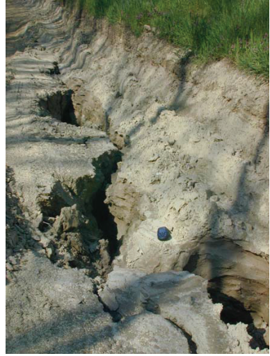
7. kép. Mélyút Jazvina puszta közelében. Az út jobb oldalán bevágódó mély eróziós barázda az oldalfal omlását készíti elő.
