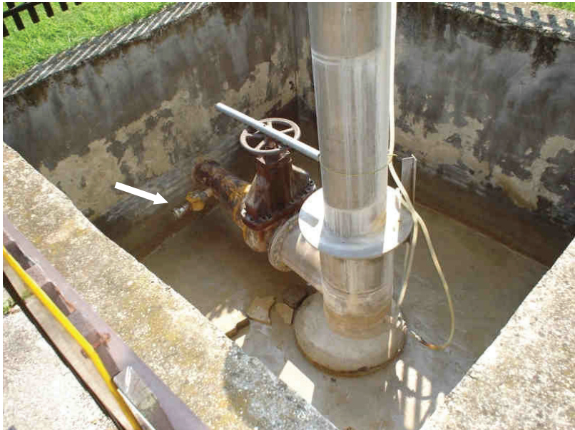
7. ábra A Harkányi Gyógyfürdő Zrt. területén elhelyezkedő Termál-VI-os kút (A nyíl a mintavételi csonkot jelöli.)
