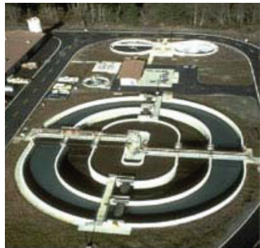
1. ábra. Orbál-típusú anoxikus-oxikus szelektoros eleveniszapos medence
