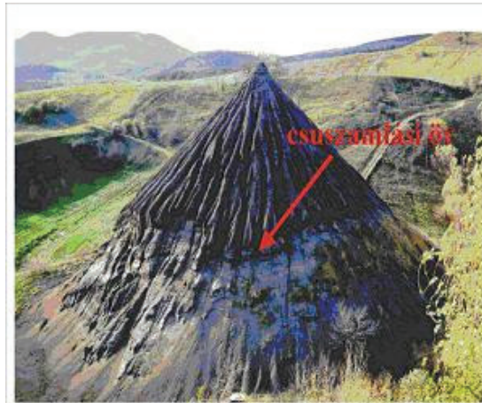
18. ábra: A fiatalabb kúpon felárkolt teteje és a körbefutó jellegzetes csuszamlási öv
