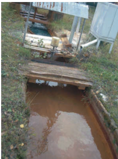
3.11. ábra: A bányavíz meszezése az altárónál
