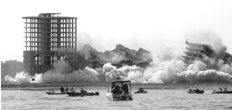
2.2 Demolizione dell'ecomostro di Punta Perotti, Bari, 2006
