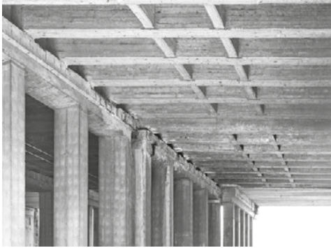
3.5 Intradosso di struttura in c.a., Padova
