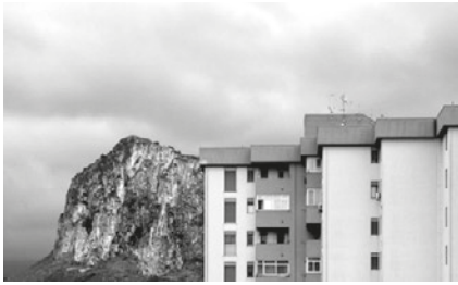
3.29 Edificio-montagna a Partinico, Palermo
