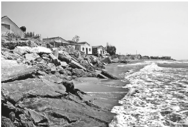
4.5 Spiãntza, case danneggiate nel segmento di Mouteli
