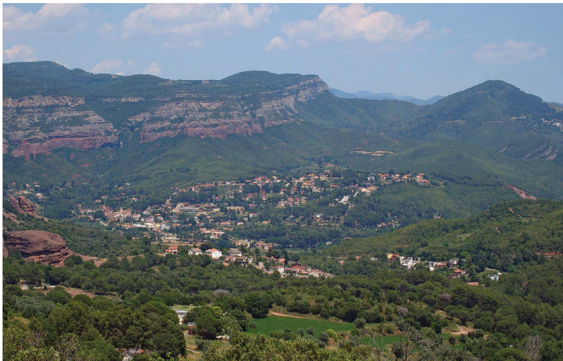
Urbanitzacions a Riells del Fai, al peu dels cingles de Bertí (Vallès Oriental). Albert Ferré i Arnau Mercadé
