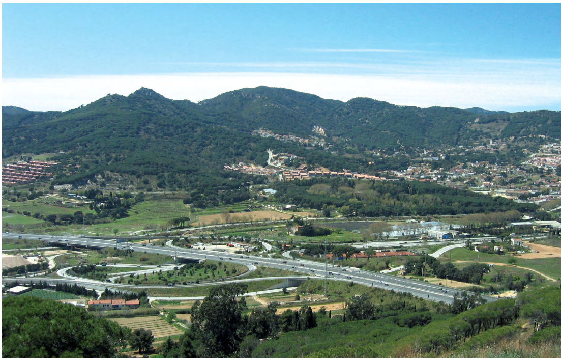
L'autopista del Maresme a l'indret d'Argentona. M. Guardiola
