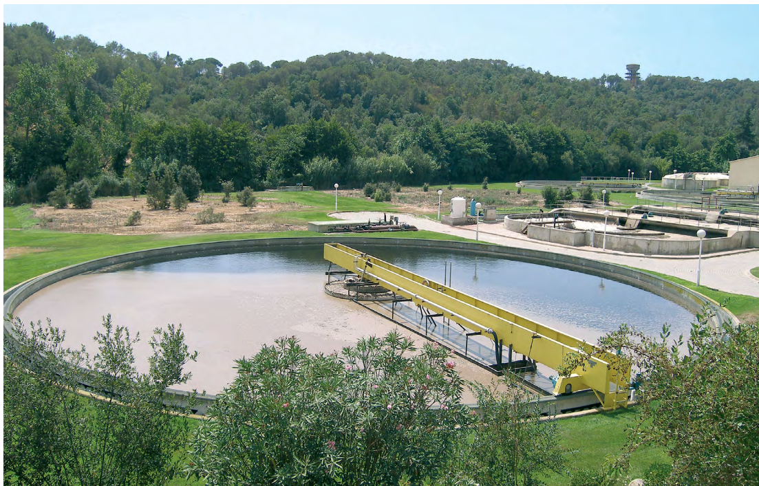
Estació depuradora de Lloret de Mar (la Selva), A. Ferré
