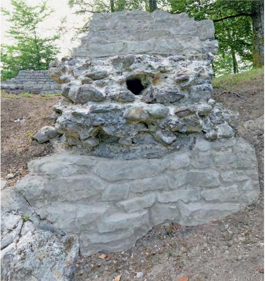
8 Blick zur westlichen Abbruchkante der Süd-mauer des Wachturms Möhlin-Fahrgraben (= Abb. 1,6) mit der Baufuge und den Negativabdrücken der Holzarmierungen im *opus caementicium*.
