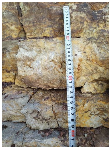
Ilustración 4.10: Rastro de falla en la arenisca.
