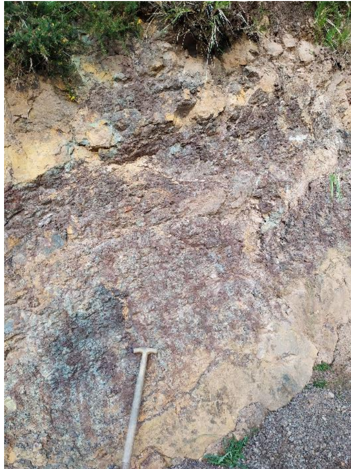
Ilustración 4.9: Imagen del escarpe principal, compuesto de arcilla y alguna alternancia de arenisca.
