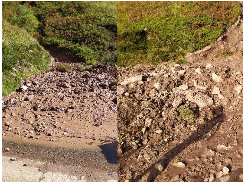
Ilustración 4.20: Movimiento 2 acumulación en la carretera (vista desde ambos lados de la carretera)
