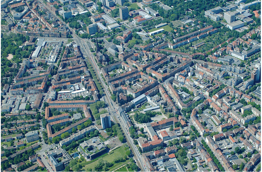
Abb. 1: Untersuchungsgebiet in der Oststadt in Karlsruhe / Quelle: Stadt Karlsruhe 2011: 18: Foto: Roland Fränkle, Presse- und Informationsamt Karlsruhe
