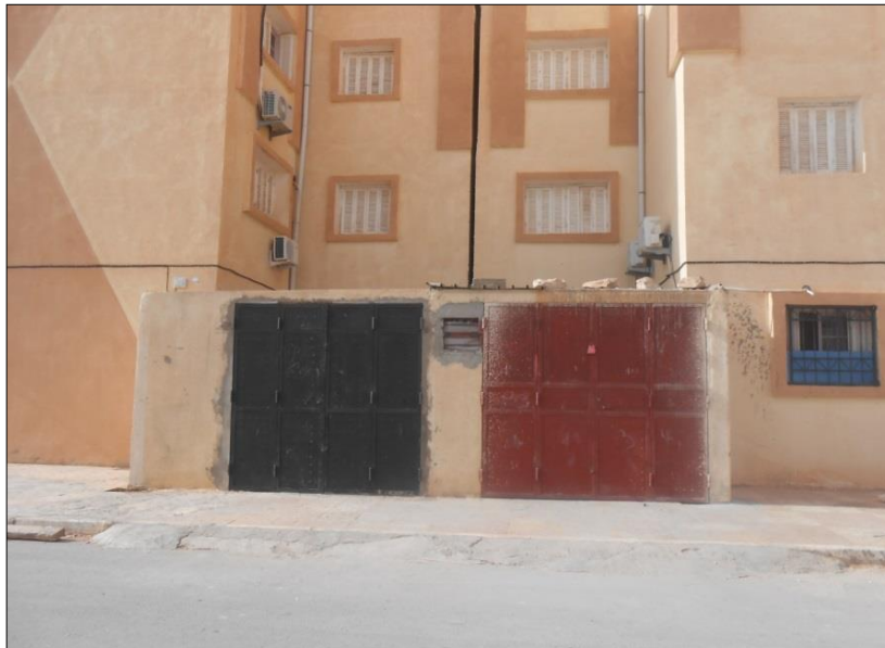
Figure 19. Construction d'un espace pour stationnement de voiture en occupant la voie publique (Source : Auteur, mars 2017)
