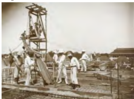
Gambar 25. Penuangan Beton dengan Peralatan Sederhana. (Sumber: colonialarchitecture.eu)
