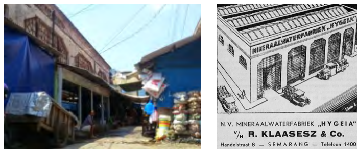
Gambar 4. Bangunan Pabrik Air Mineral Hygeia (1908) Kiri: Kondisi bangunan sekitar tahun 2015 – Gambaran bangunan pabrik Hygeia dalam iklan (Sumber: raisoanteng.blogspot.com ; yogifajri.blogspot.com )
