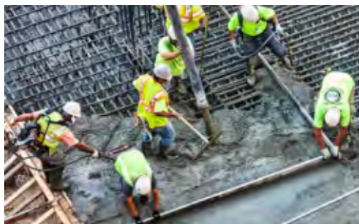
Gambar 26. Penuangan Beton dengan Peralatan Masinal – Beton dialirkan melalui selang. (Sumber: exakttime.com)
