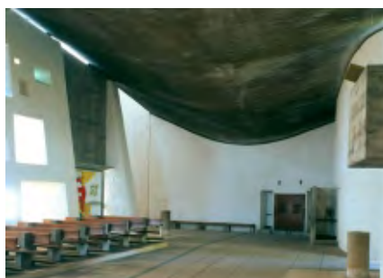
Gambar 3. Chapelle Notre Dame du Haut, Ronchamp, France (1950-1955) Atap lengkung dari beton bertulang tampak seperti melayang tanpa disokong banyak kolom (Sumber: fondationlecorbusier.com )
