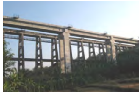
Gambar 17. Jembatan Kereta Kalibelang Lama (1916) dan Baru (2012) (Sumber: puadhasan.blogspot.com )
