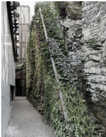
Figura 59 - Jardim vertical no exterior
