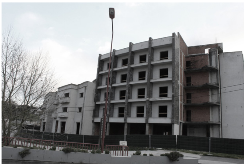
Figura 26 - Fachada do edifício de intervenção
