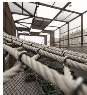
Figura 37 - Pormenor da Estrutura tensionada | Pavilhão do Brasil
