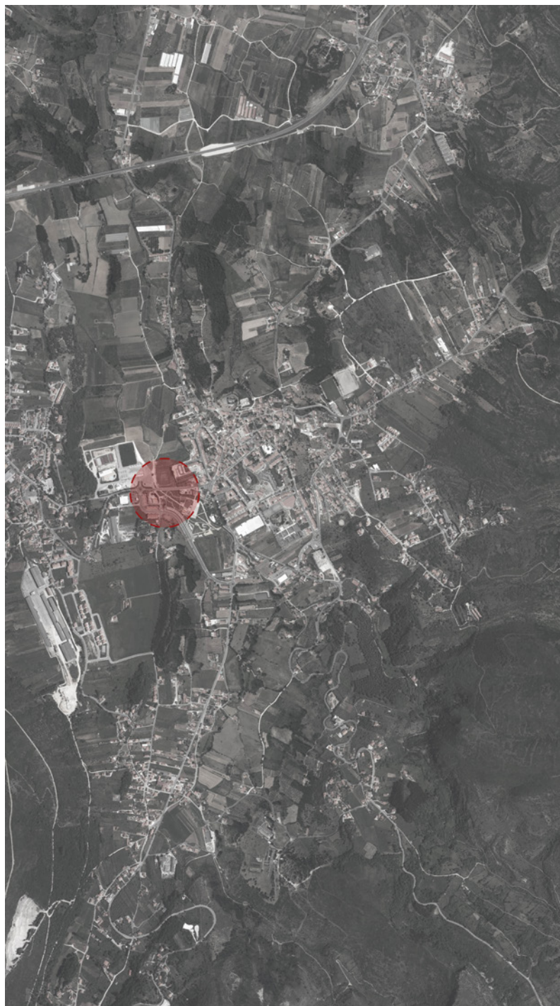
Figura 68 - Fotografia Aérea da Área de Intervenção | Vila de Porto de Mós
