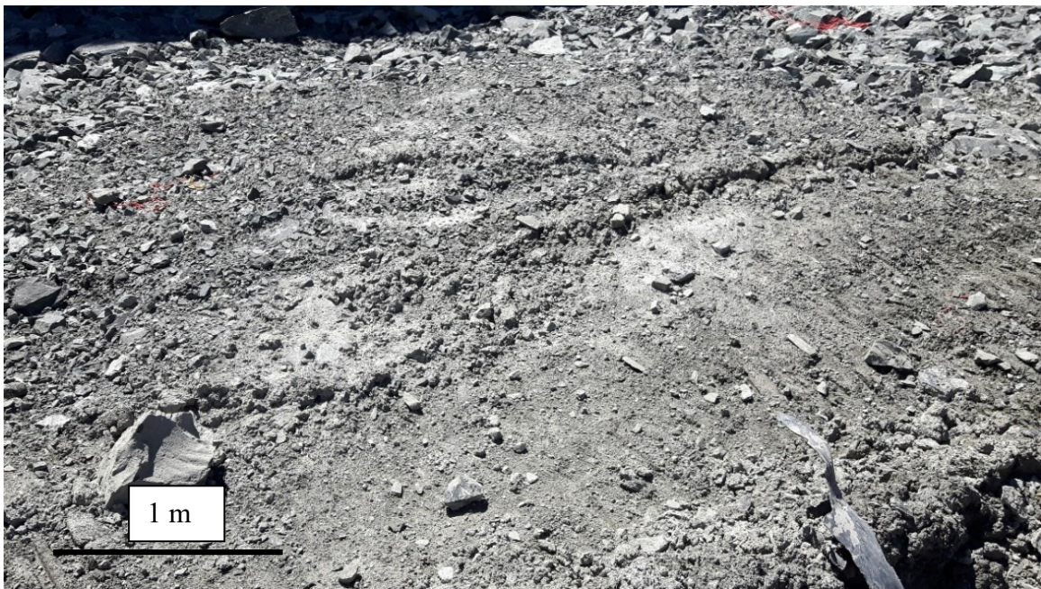
Figure 6 : Sommet d'un « muck pile » en cours d'extraction. Les empreintes des chenilles des engins de chantier sont visibles.
