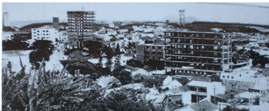
Figura 16 - Edifícios em construção no centro de Guarapari década de 1960
