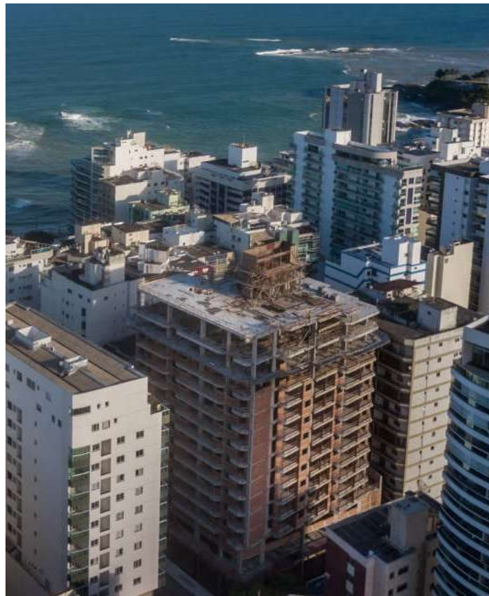
Figura 30 - ed. Turmalina em construção com 15 andares
