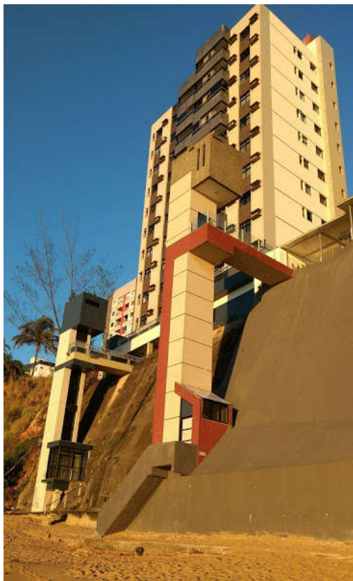
Figura 38 - Dois elevadores que dão acesso à praia da areia preta, um do edifício Malibu e o outro de uma casa residencial.
