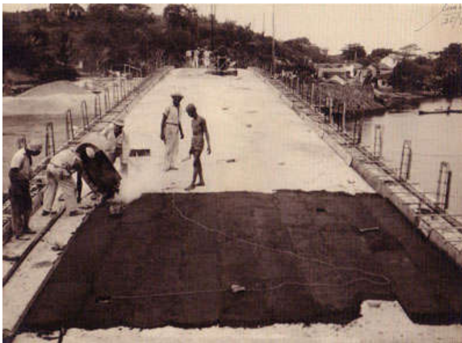
Figura 5 - Construção da ponte do município de Guarapari.
