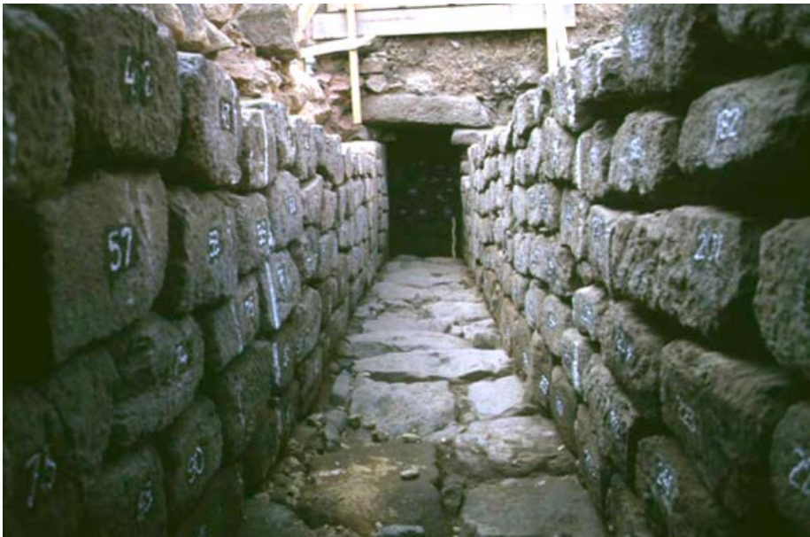
Figura 10. Fotografia da Cloaca encontrada no “Ex-Albergue Distrital” (atual Biblioteca Lúcia Craveiro da Silva).
