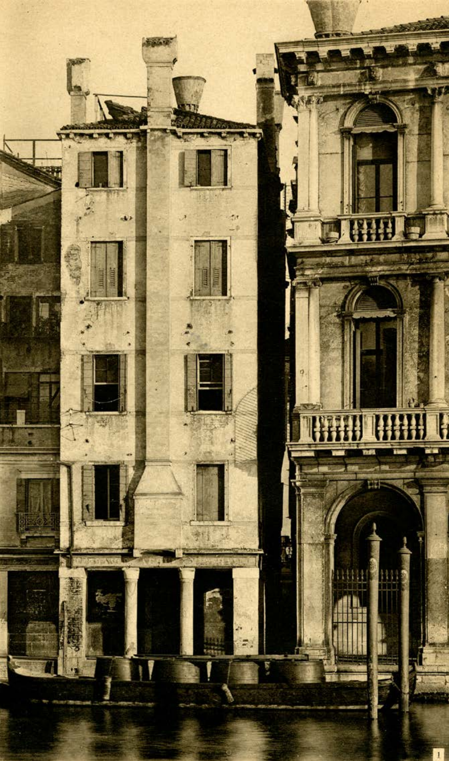
Figura 3. Venezia, Fondamenta del Carbon sul Canal grande, la stretta calle della Scimmia tra palazzo Dolfin Manin e a sinistra il palazzetto su portico che verrà demolito per allargare calle della Scimmia (da Relazione 1891, fig. 1).
