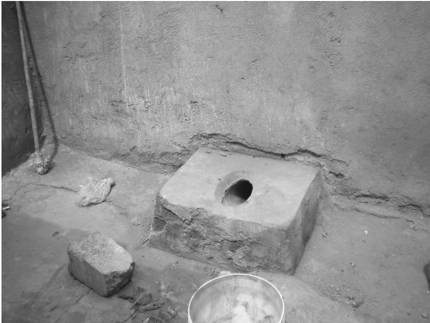
Figure 5.3 Traditional pour flush toilet
