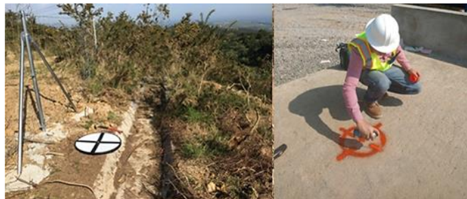
Figura 2.15. Señalización en puntos de control para sobrevolar la aeronave no tripulada.
