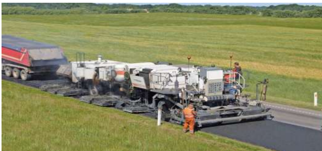
Слика 113 - Производња и уграђивање рециклираног слоја топлим поступком
