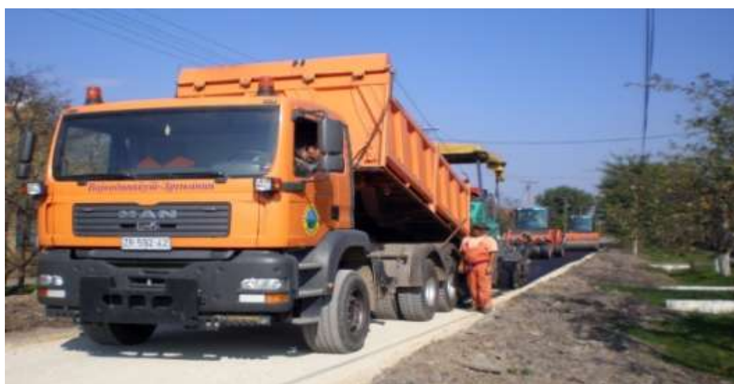
Слика 109 - Уграђивање битуменом везаних материјала на локалној саобраћајници
