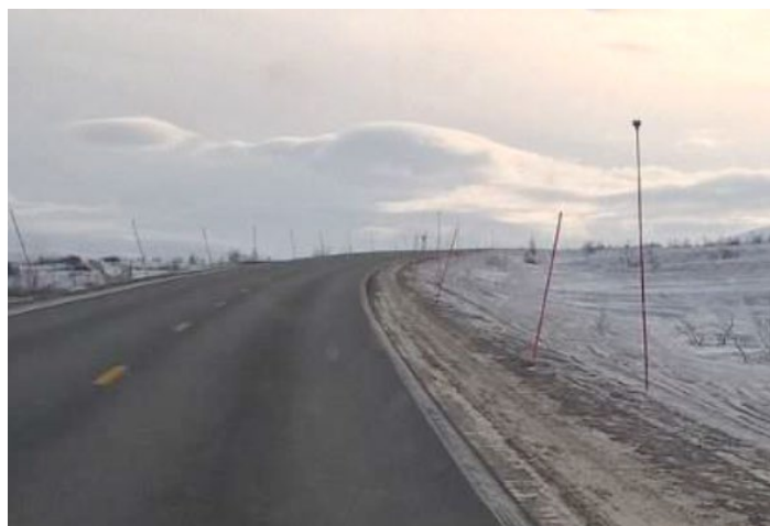
Figur 4. Jernstikker langs veien påmontert mottaker med blinklys.
