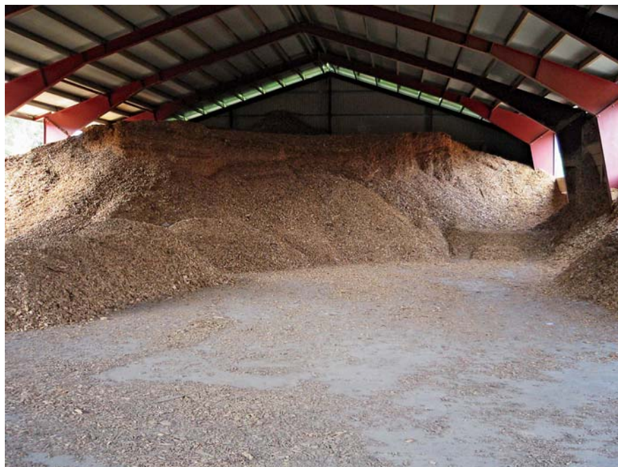
Flislagring under tak på Dokka Biovarme.
