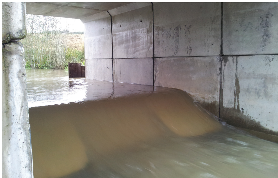
Figur 1. Vannstrømmen gjennom Crump-overløpet i Hotranelva.
