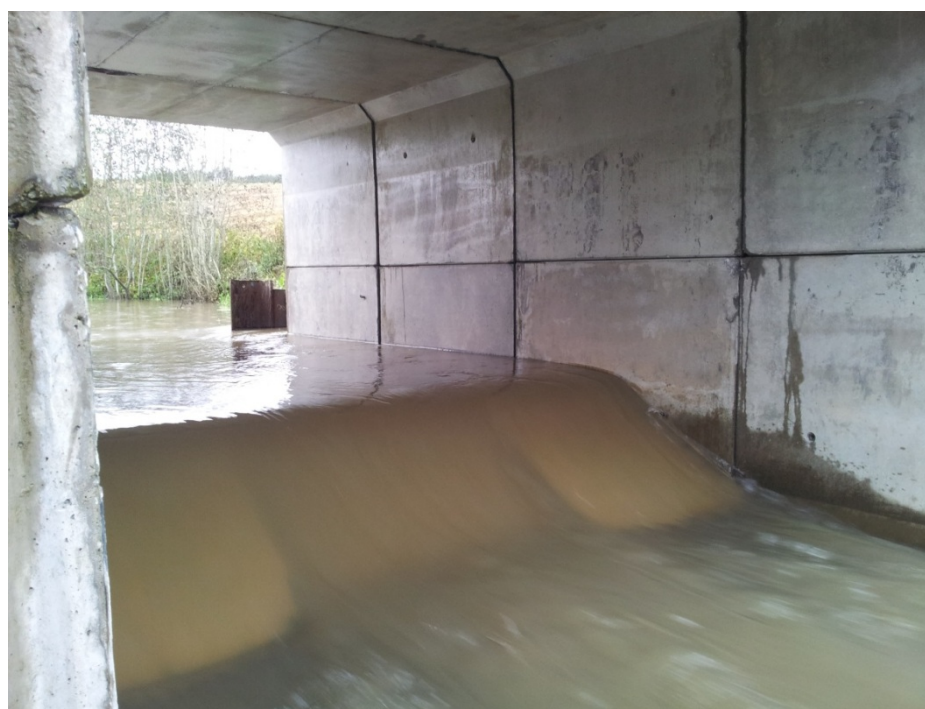
Figur 1. Vannstrømmen gjennom Crump-overløpet i Hotranelva.
