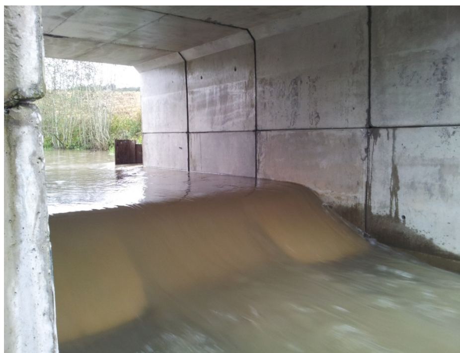
Figur 1. Vannstrømmen gjennom Crump-overløpet i Hotranelva.
