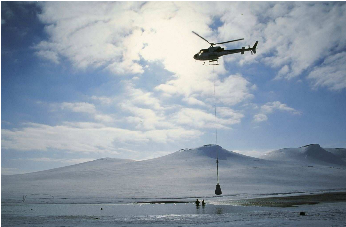
Bildet viser utlegging av grus i Bjornesfjorden i april 2002. Foto: LFI-Unifob v/Helge Skoglund.
