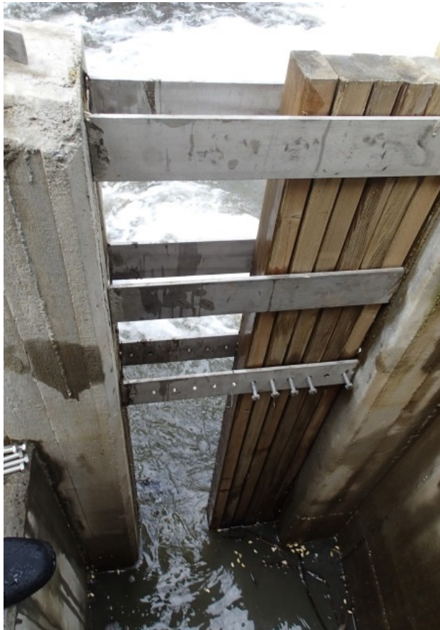
Eksempelbilde fra (3 m høy) nålestengsel i en spaltetrapp som Uni Research Miljø designet i Akerselva, Oslo
