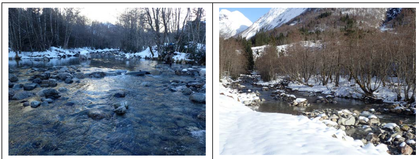
Figur 25. For å sikre den utlagte gytegrusen mot utspyling ble det lagt ut store steiner i området nedenfor gytegrusen. Det ble i tillegg laget en lavvannsrenne for å sikre god vanngjennomstrømning og vandringmuligheter ved lav til middels vannføring. I tillegg ble det lagt ut steiner og blokker for å stabilisere gytegrusen og for å øke den hydromorfologiske variasjonen i det etablerte dypområdet.
