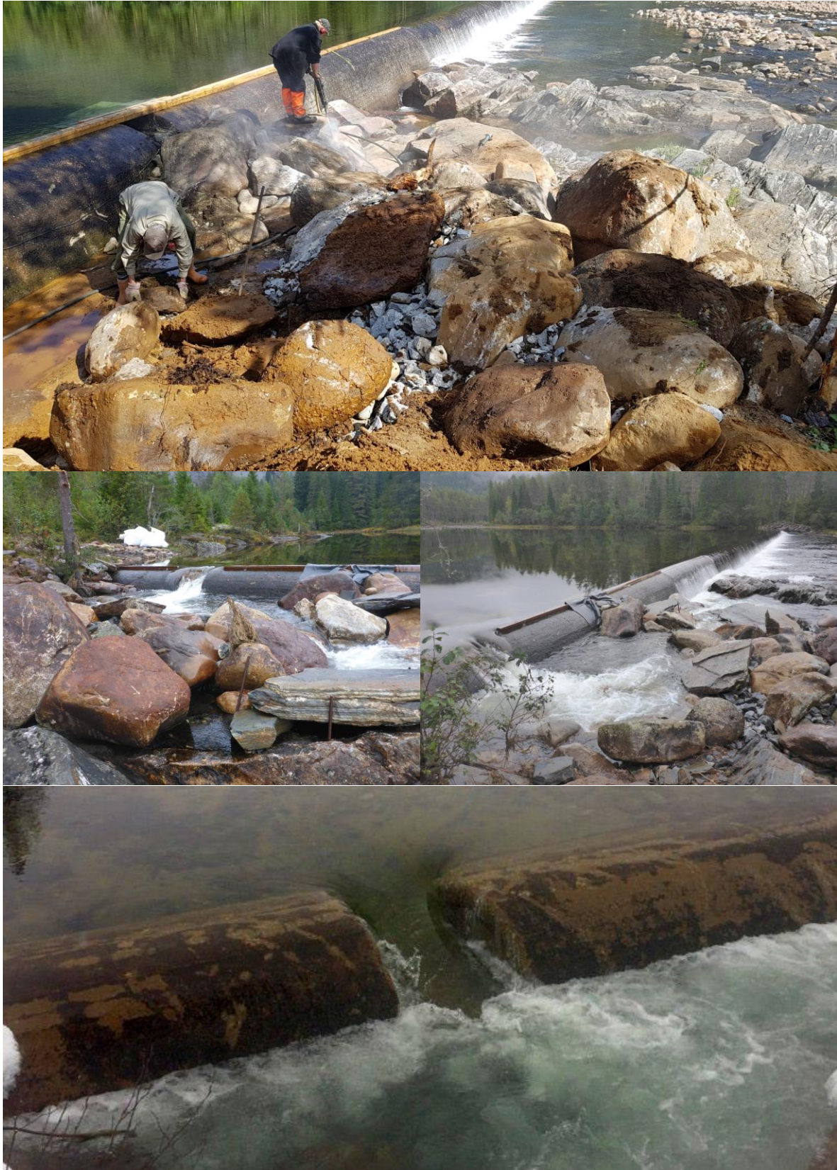
Figur 57. Byggingen (øverst), nær ferdigstilt og ferdigstilt (nederst) fiskepassasje ved betongterskelen.
