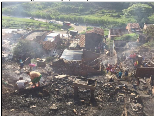
Imagen 1. Fotografía después del incendio.
