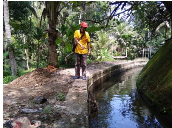
Gambar 3. Sumber air untuk pompa hidram
