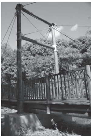
Figura 8 – Bloco de fundação e mastros compondo uma torre da passarela
