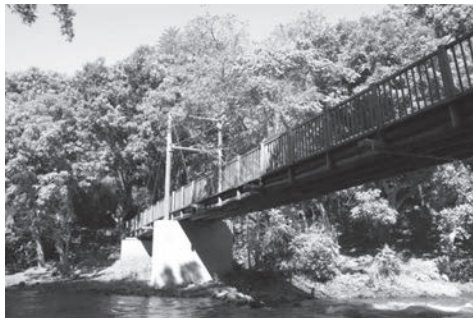
Figura 7 – Vista longitudinal da passarela Parque dos Saltos, Brotas, SP
