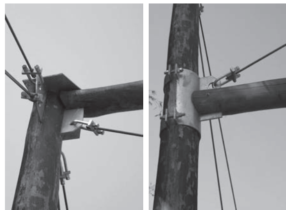
Figura 9 – Ligações nos mastros da passarela
