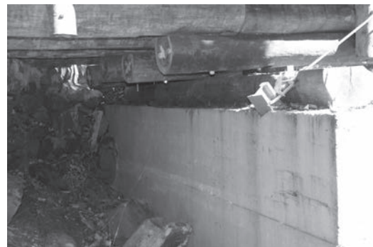
Figura 11 – Ancoragem dos estais externo no berço de apoio
