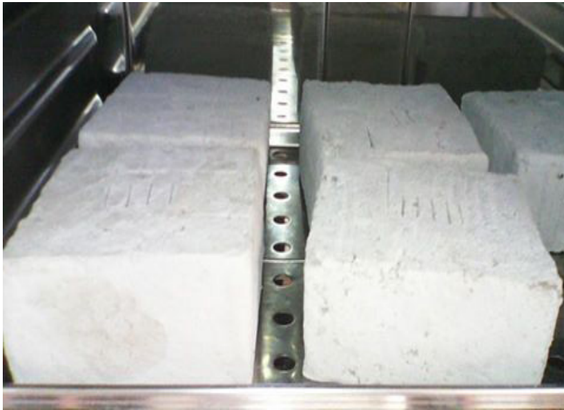
Figura 2. Unidades cerámicas macizas con eflorescencia total en la superficie (velo de secadero).
