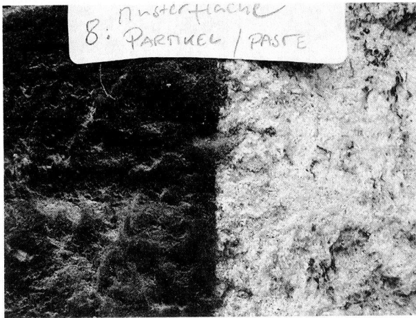
61: Versuchsfeld zur Reinigung nach der Applikation einer kombinierten Reinigungsvariante am Beispiel von Probe MF 2/8 auf der Nordostseite des Turmes der porta praetoria (2002).
