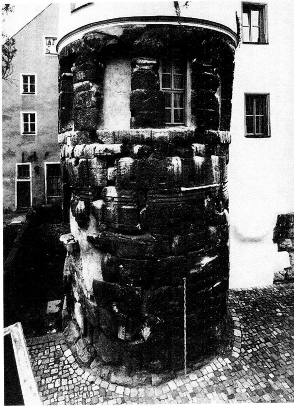
45 29: SW-Fotografie von 2000: Nordansicht aller Turmgeschosse (Uwe Gaasch).
