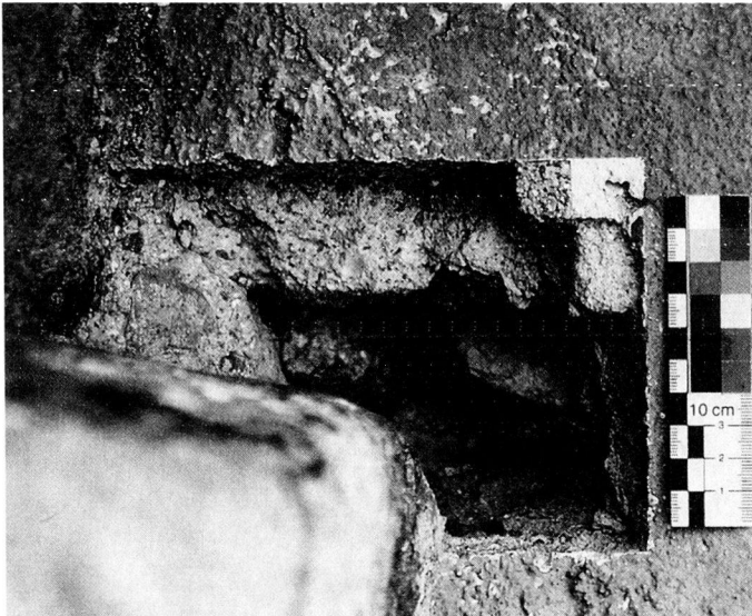
48: Befundschnitt durch den Putzmörtel von 1958 bis zum ersten nachweisbaren Mörtel, der aufgrund der Zusammensetzung und stratigraphischen Lage am Bauwerk als frühmittelalterlich zu klassifizieren ist. Dazwischen liegen ein spätmittelalterlicher Mauermörtel mit Ziegelsteinen (15. Jh.) und ein Ausbesserungsmörtel auf Zementbasis (1910). (Ostfassade Rundbogenfenster).
