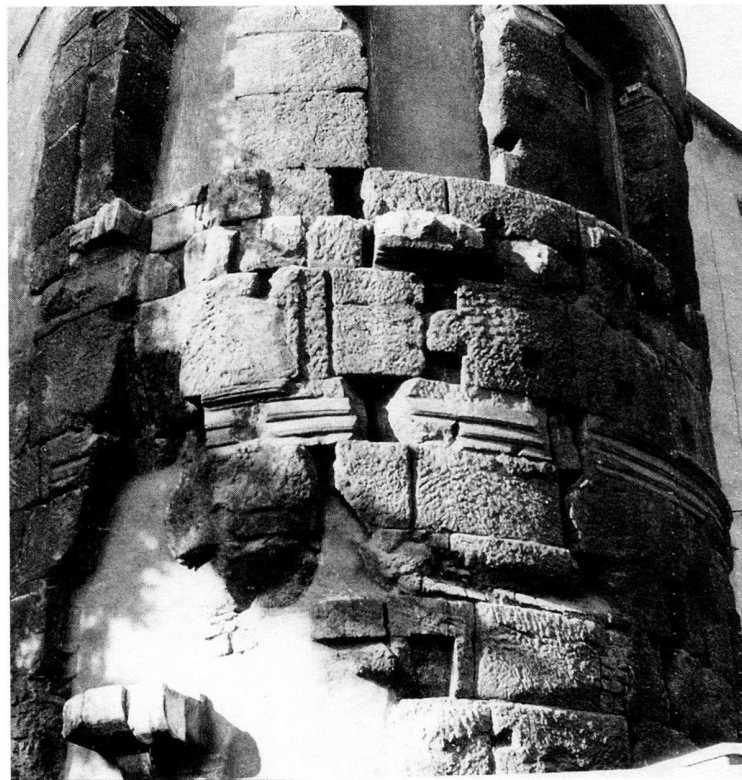
28: SW-Fotografie von 1971: Nordostansicht des Turmes mit bautechnischen Details wie dem Kaminzug mit abschließendem Kragstein (li. unten) und Eisenanker (re. oben); (BLFD).
