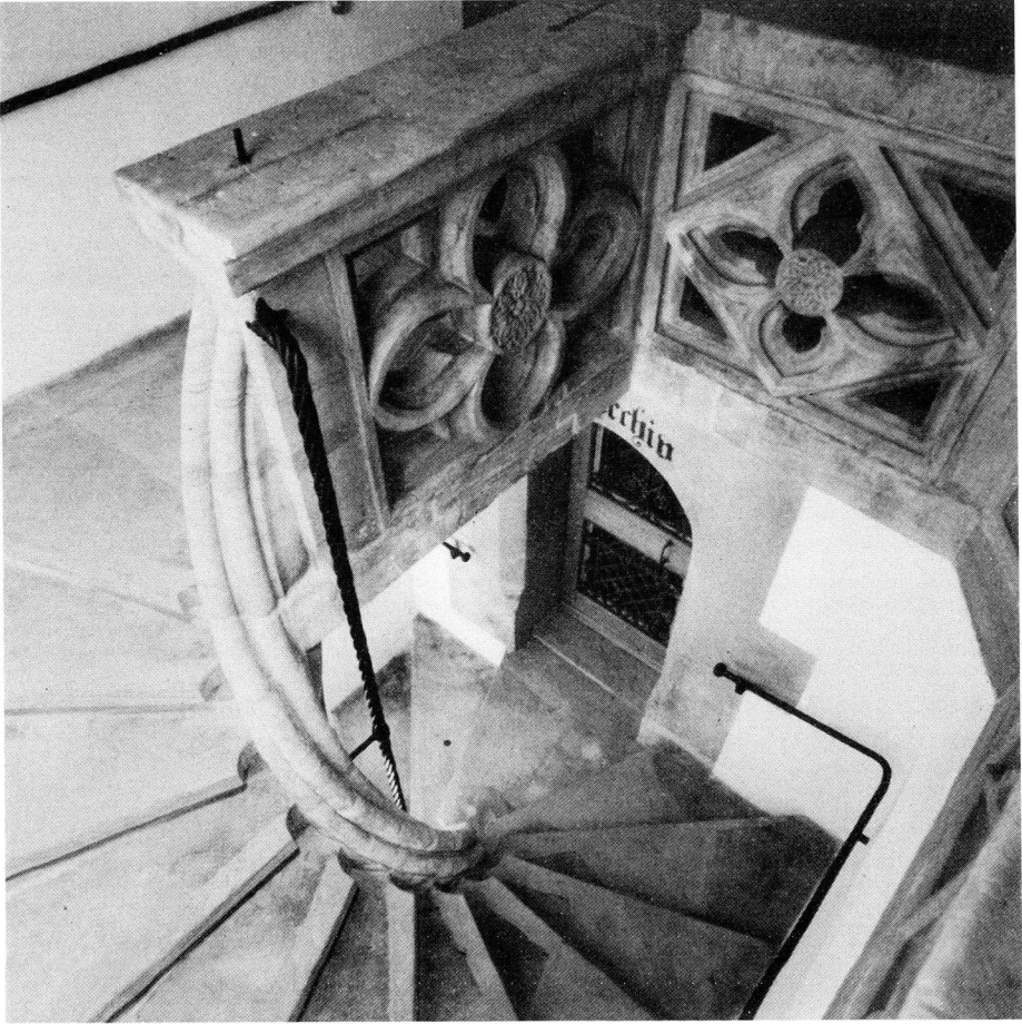
Abb. 2: Das alte städtische „Archivgewölbe“ im Mezzaningeschoß des Amberger Rathauses.
