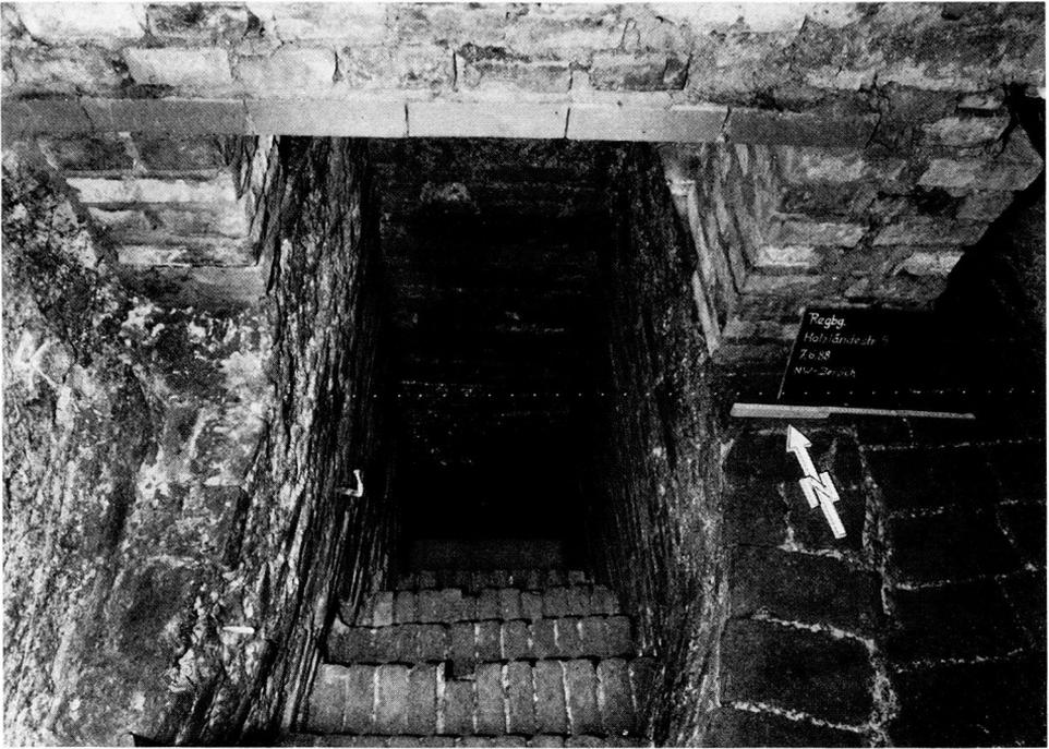
Abb. 11: Die Mikweh während der Dokumentation. Noch unverputzt die neue Stützkonstruktion der aufliegenden Mauer b. Blick nach Norden
