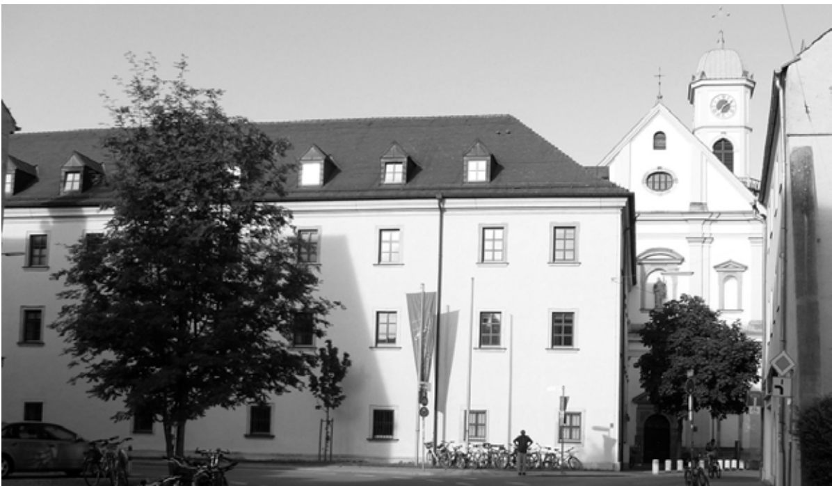
Abb. 5: ehem. Bezirksamtsgebäude, Andreasstr. 9, Regensburg-Stadtamhof
