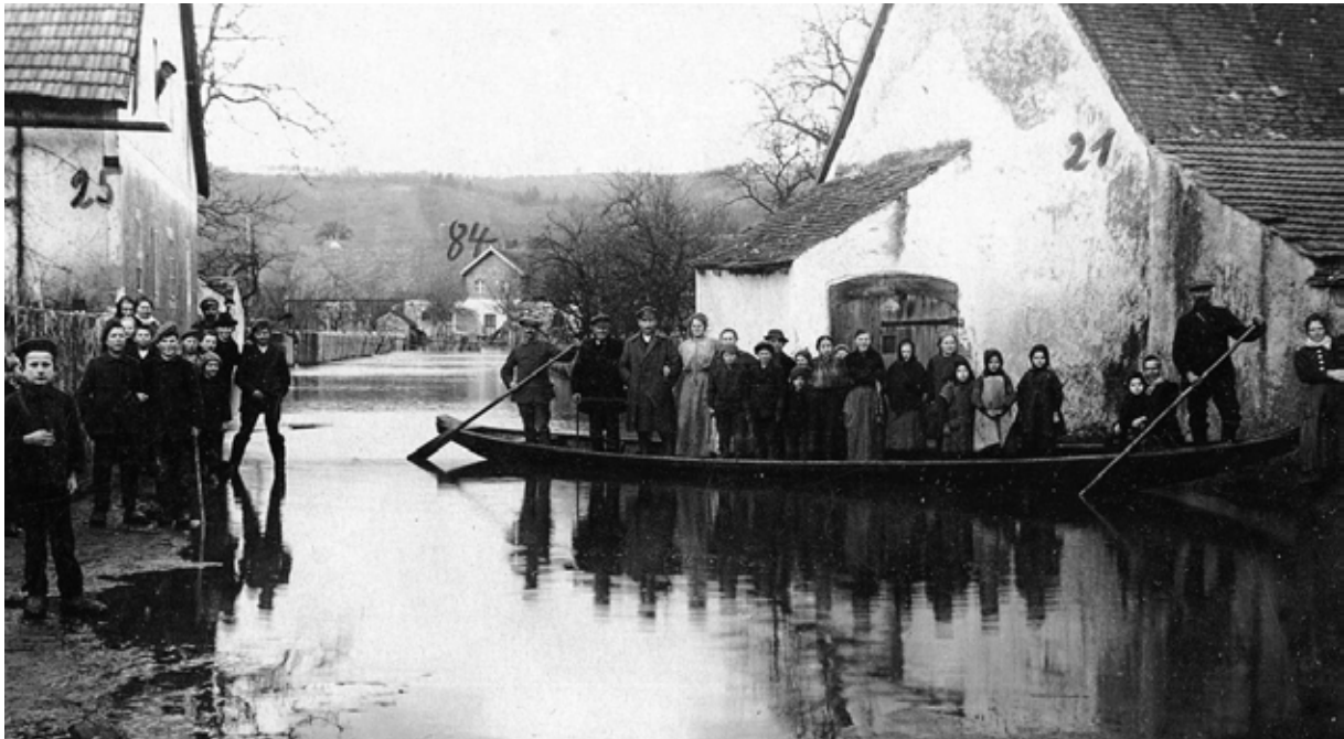
Abb. 10: Hochwasser von 1920 in der Kirchstraße
