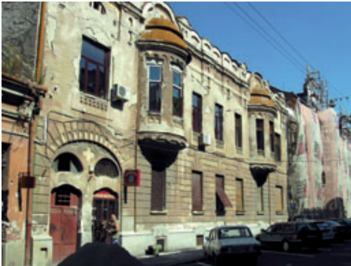
Abb. 5: Auffallend viele Sanierungen – an Hütten und Palästen
