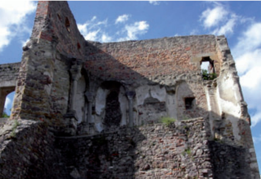
Abb. 7: Blick auf die romanische Burgkapelle, erbaut um 1060/70
