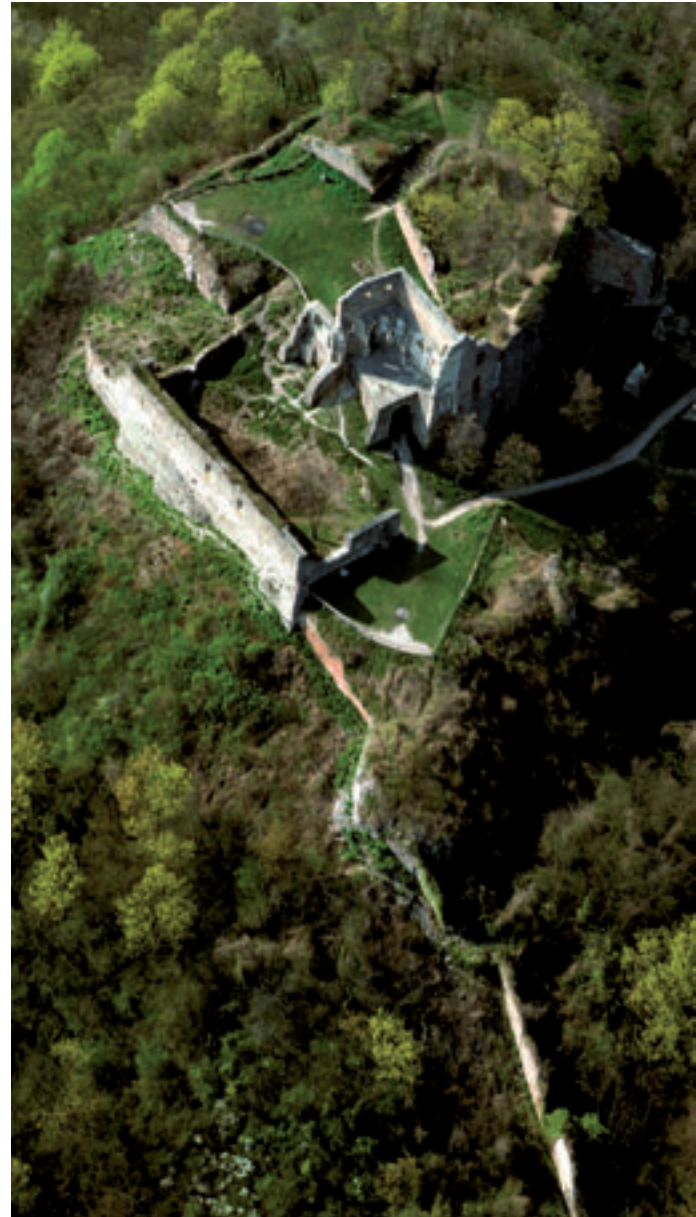
Abb. 1: Luftbild der Burganlage vor der Sanierung
