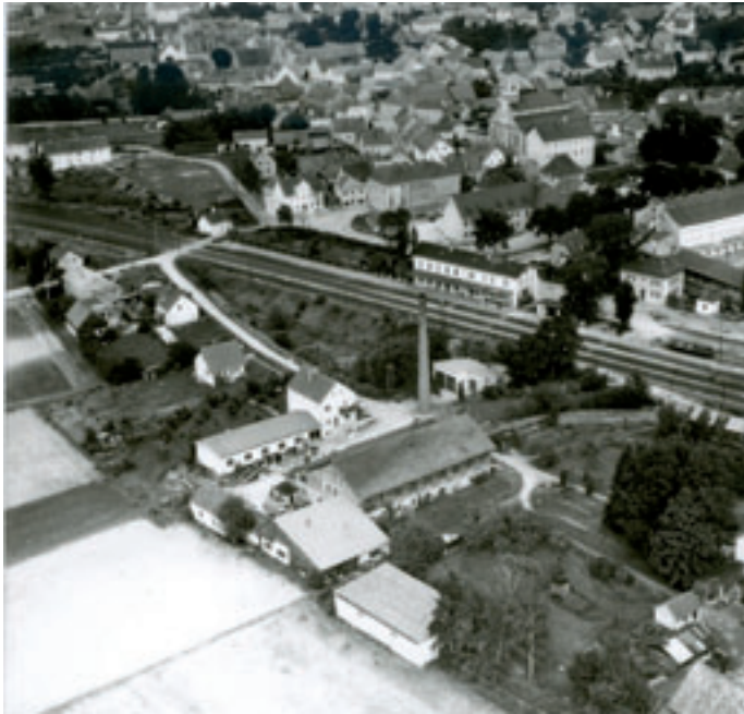
Abb. 14: Bahnhof Regenstauf mit Konservenfabrik Pfannenstiel (im Vordergrund) und Dampfziegelwerk Puchner (am rechten Rand): Der unmittelbare Anschluss an das Hauptbahnnetz war für transportintensive Industriebetriebe ausschlaggebend bei der Standortwahl.
