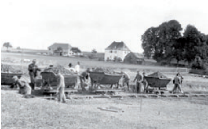
Abb. 8: In Folge des geringen Gefälles und des langsam fließenden Wassers sedimentieren die Abflussrinnen leicht zu und müssen von Zeit zu Zeit geräumt werden: Reichsarbeitsdienst beim Räumen des Sieberbaches
