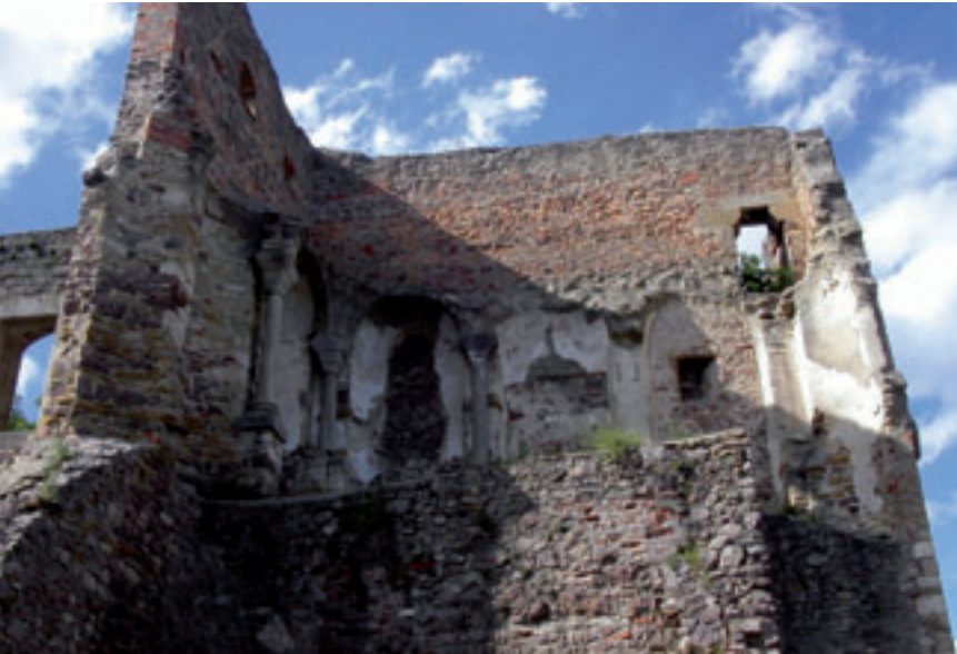
Abb. 7: Blick auf die romanische Burgkapelle, erbaut um 1060/70
