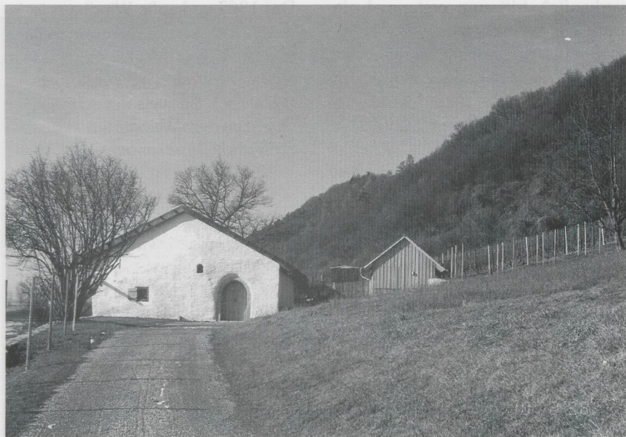
Das Biethaus in Bach nach der Renovierung
