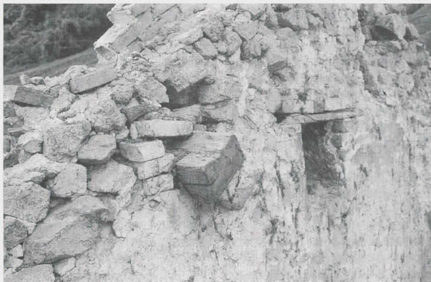
Ansicht Westgiebel Südwestecke von innen, Detail Mauerwerk der Giebelaussteifung und Pfettenstumpf des Vorgänger-Dachwerkes (dendrochronologisch datiert 1615)
