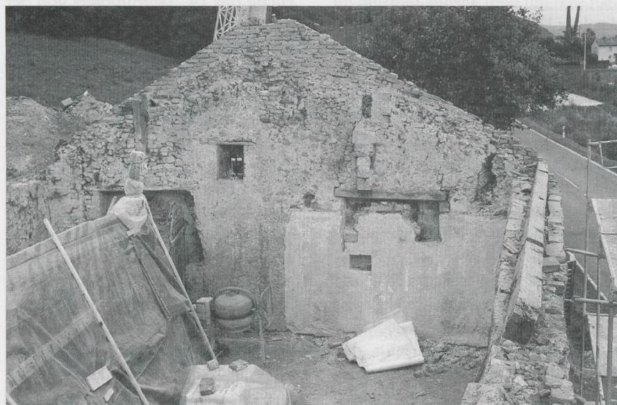
Ansicht Ostgiebel von innen nach Abbau Dachstuhl
