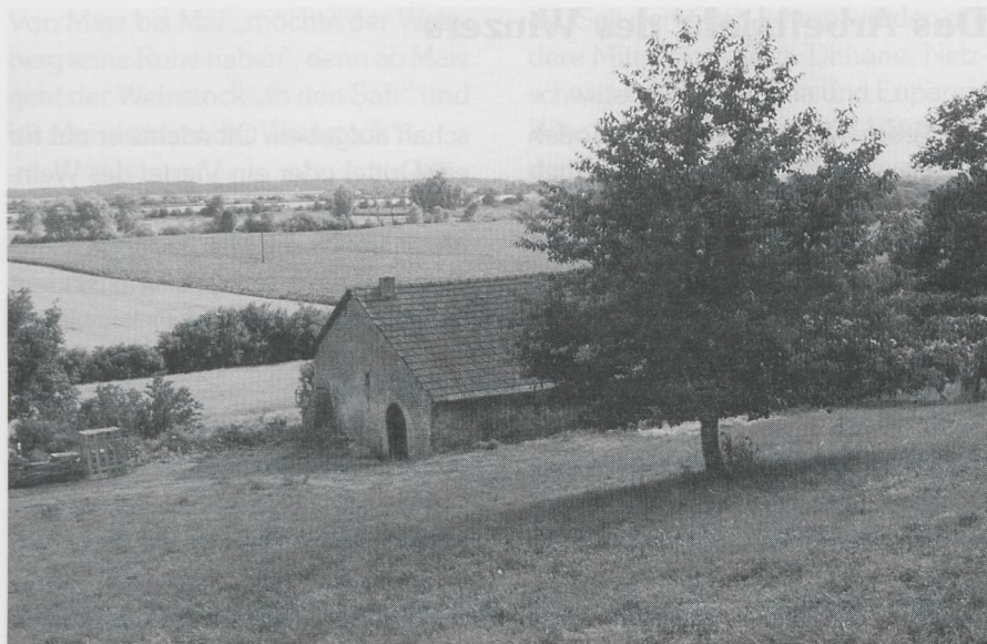
Biethaus nach Freilegung des Umfeldes, Ansicht von Nordosten
