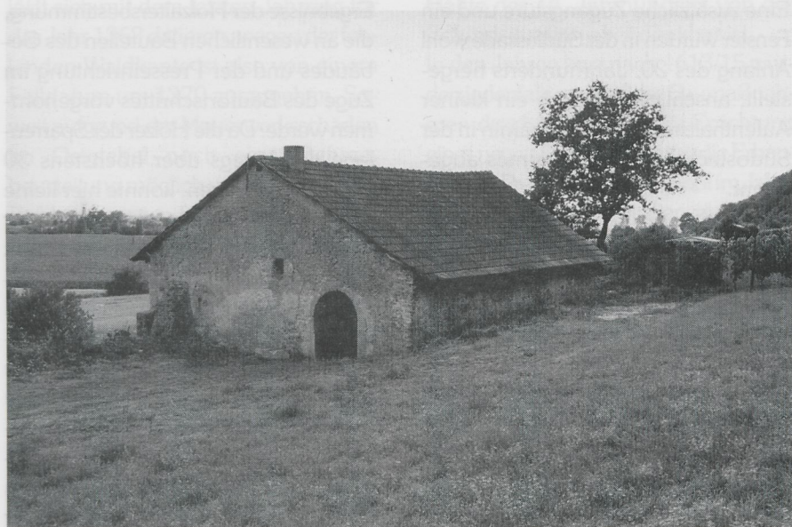
Das Biethaus in Bach vor der Renovierung
