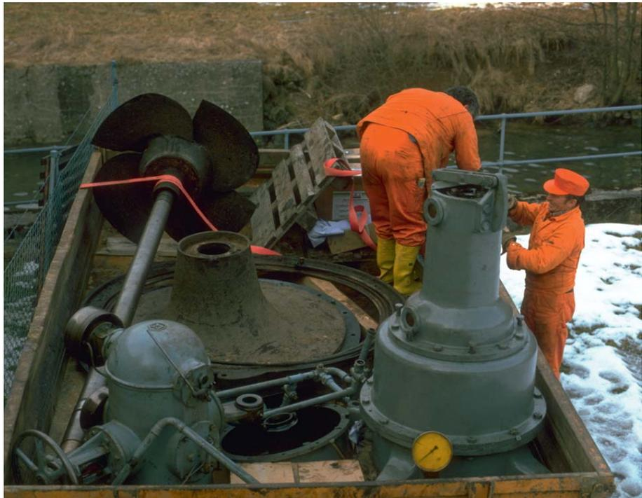
Abb. 88: Generalüberholung Turbine Wasserkraftwerk
