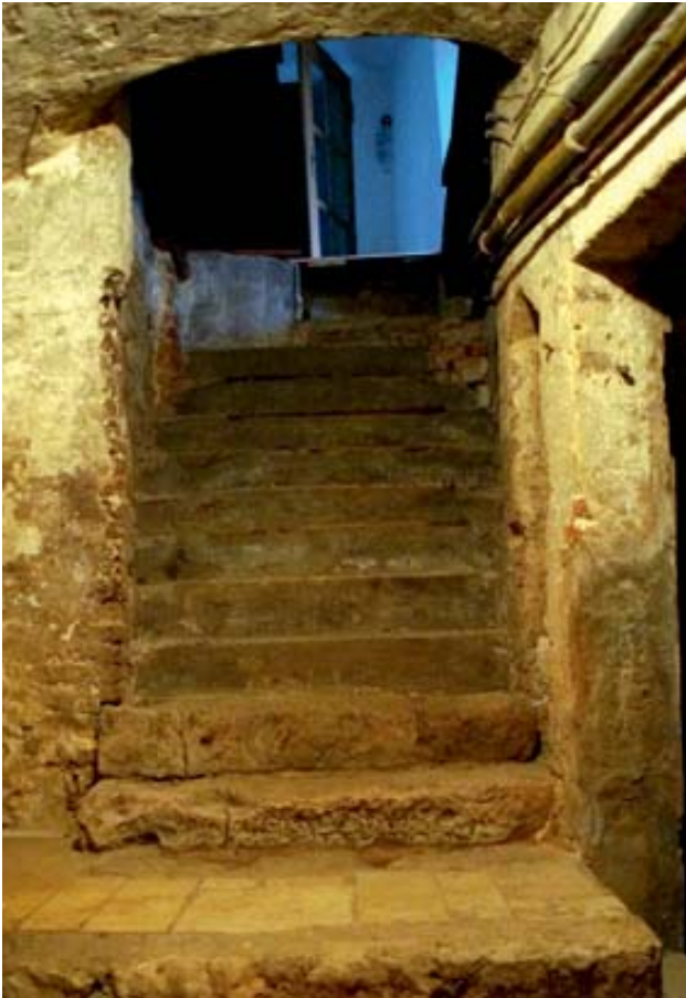
Treppenabgang zu dem noch erhaltenen Innenkeller
