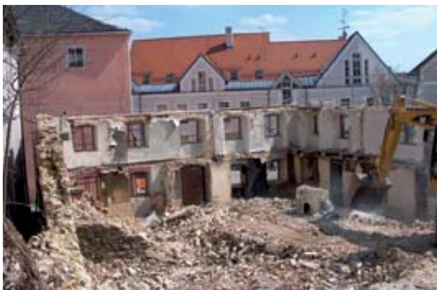
2004 Abriss bis auf Außenmauer
