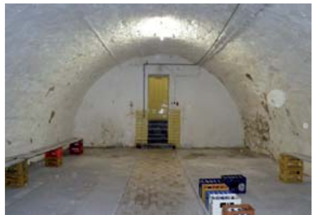
Der ehemalige Sommerkeller nach der Einstellung des Braubetriebs
