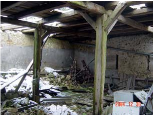
2004, Abbruch des Stadels samt des darunterliegenden Sommerkellers
