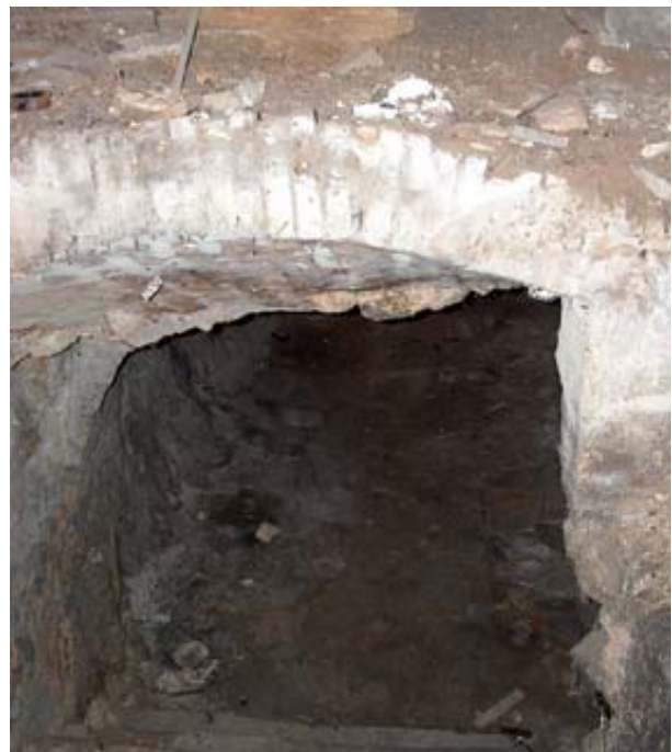
Abgang zum Schenkeller vor Verfüllung
