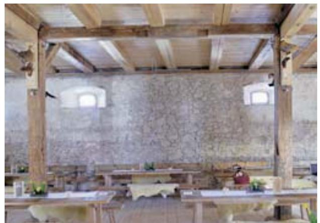
Alle Hölzer waren aus handbehauenen Fichtenbäumen hergestellt, abgebunden und montiert. Besonders auffallend an der Dachkonstruktion ist, dass man die vorhandenen Sparren mit dem „Zopf“, das heißt mit dem dickeren Ende des Stammes und folglich mit der unteren Seite nach oben montiert hatte.
