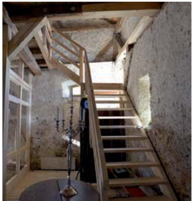
Die auf der Oberseite der Holzbalkendecke neu verlegten Nut- und Federbretter aus Fichtenholz dienen zugleich als Fußbodenbelag. Ihre Befestigung erfolgte dem historischen Vorbild entsprechend durch sichtbare Vernagelung.
