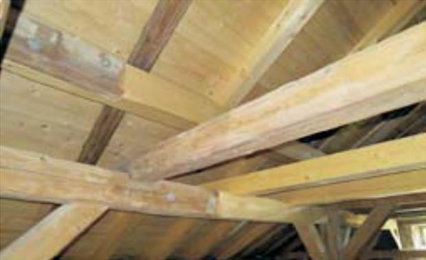
Fehlende Kehlbalken wurden neu ergänzt und mit den Sparren verzapft. Die Sparrenkonstruktion musste an vielen Stellen durch querschnittsgleiche Ergänzungen – die alle verplattet und mittels Stabdübel wieder miteinander verbunden wurden – instand gesetzt werden.
