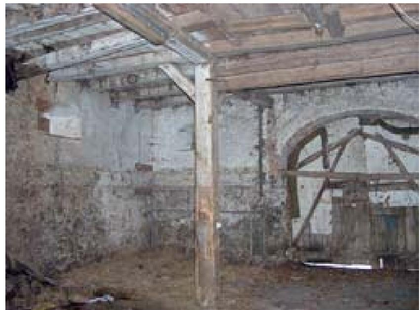
Beim Dachtragwerk selbst handelt es sich um einen Pfettendachstuhl mit 2-fach stehendem Stuhl und mit in die Sparren eingezapften Kehlbalken.
